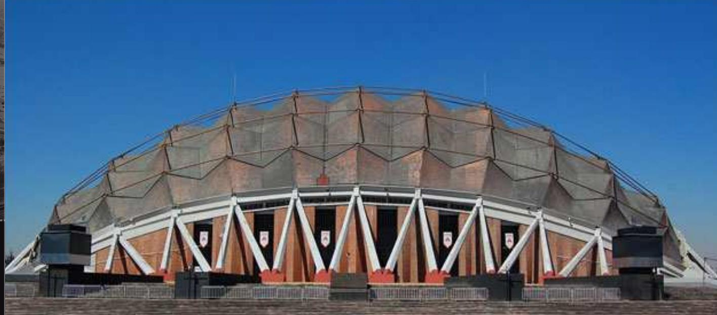
además de dar forma a pórticos de acceso al recinto. Otros pilares más esbeltos e inclinados en forma de V fungen como soportes hacia la estructura externa, que forma una primera rampa que circunda al recinto.
